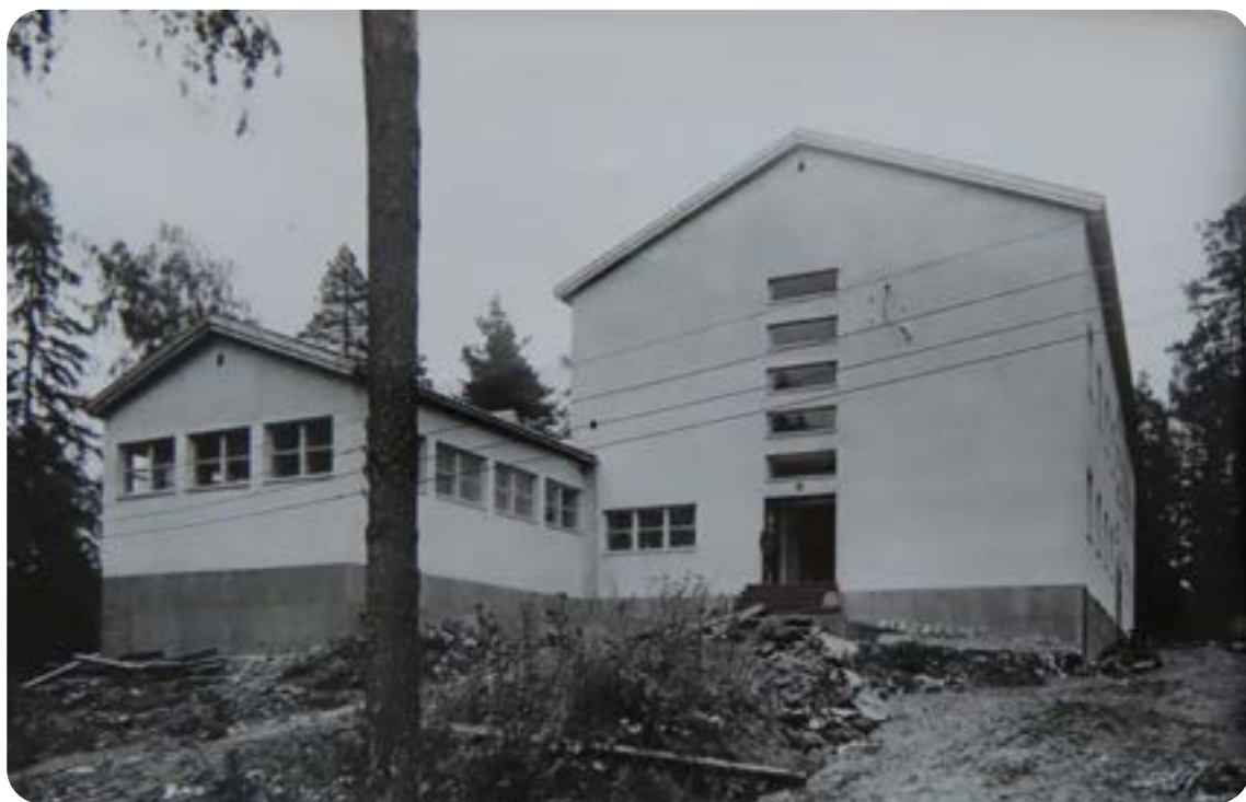
Vuonna 1942 valmistunut silloin vielä kaksikerroksinen iso asuntola ja sen vasemmalla sivustalla sijainnut kirjastosiipi. Pihatytöt ovat vielä tekemättä ja asuntolan rappusilta puuttuvat kaiteet. TAK.
