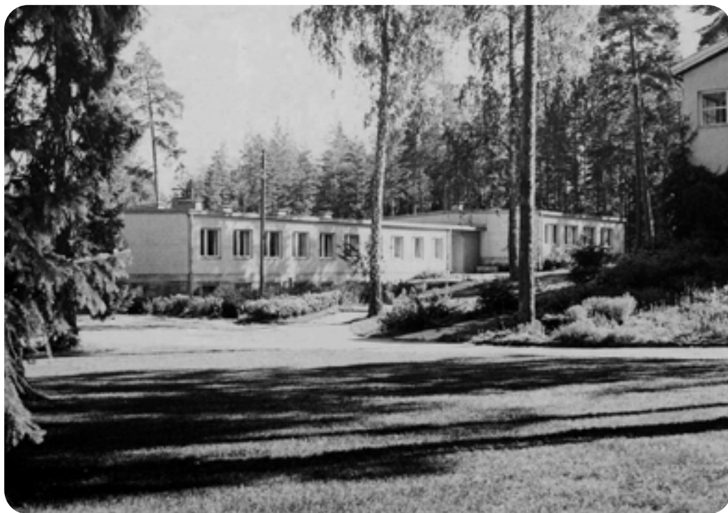
Samaan aikaan rivitalon kanssa rakennettu pieni asuntola eli Tipula. TAK.
