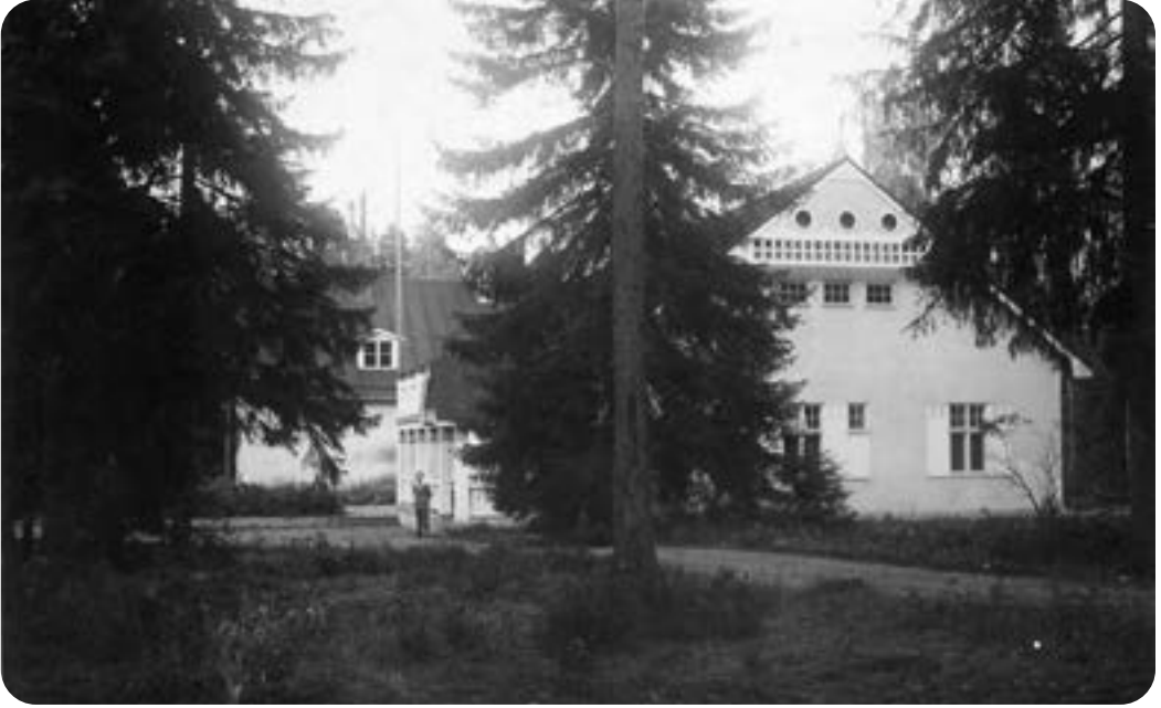
Työväen Akatemian päärakennus ennen kuin sen etualalla näkyvään länsipäätyyn valmistui kesällä 1931 juhla- eli luentosalin sisältänyt lisäsiipi. Rakennustöiden yhteydessä rakennuksen julkisivulta poistettiin osa kuistirakennelmista ja niiden mukana myös parveketerassi. TAK.
