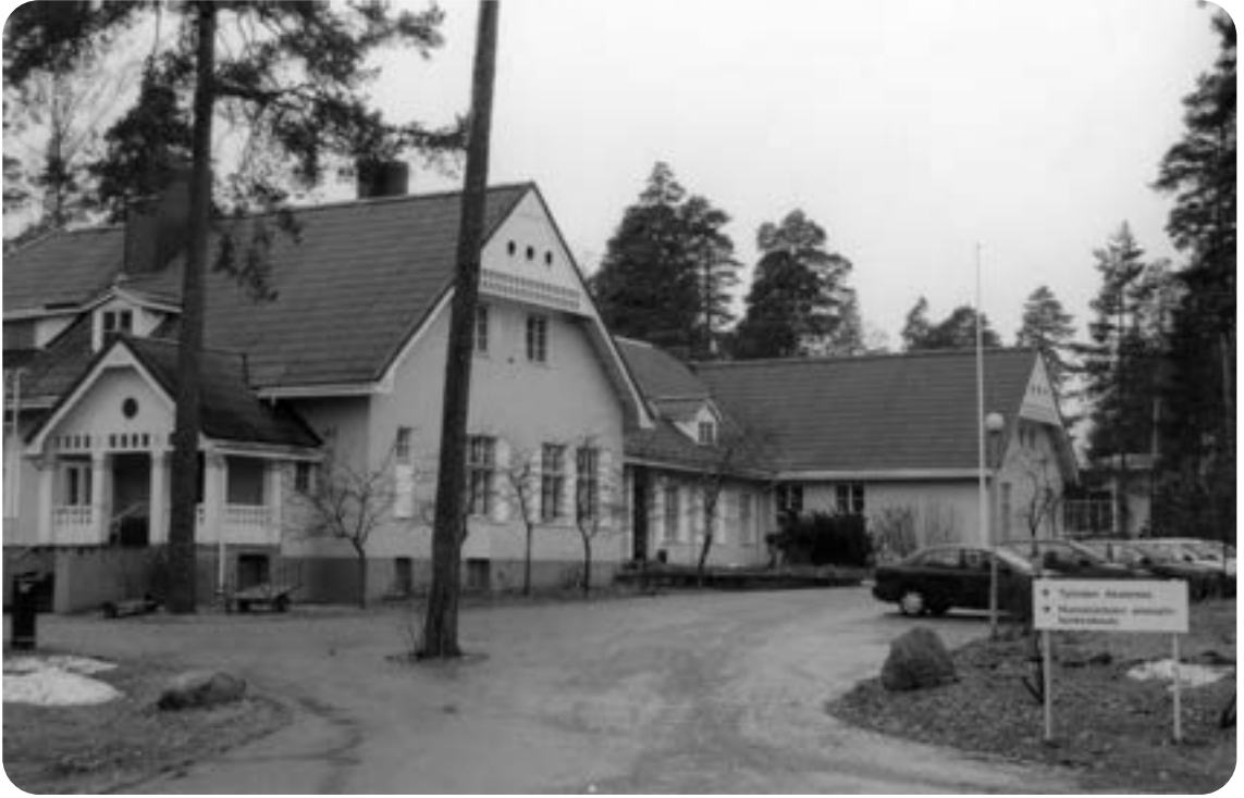
Uusi aika on koittanut. Humakin kyltti on ilmestynyt Työväen Akatemian päärakennuksen edustalle. TAK.
