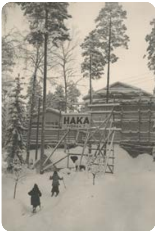
Rakennuskunta Hakan työmaata vuonna 1942. Myöhemmin isona asuntolana tunnettu Työväen Akatemian oppilasasuntola on noussut harjakorkeuteen saakka. TAK.
